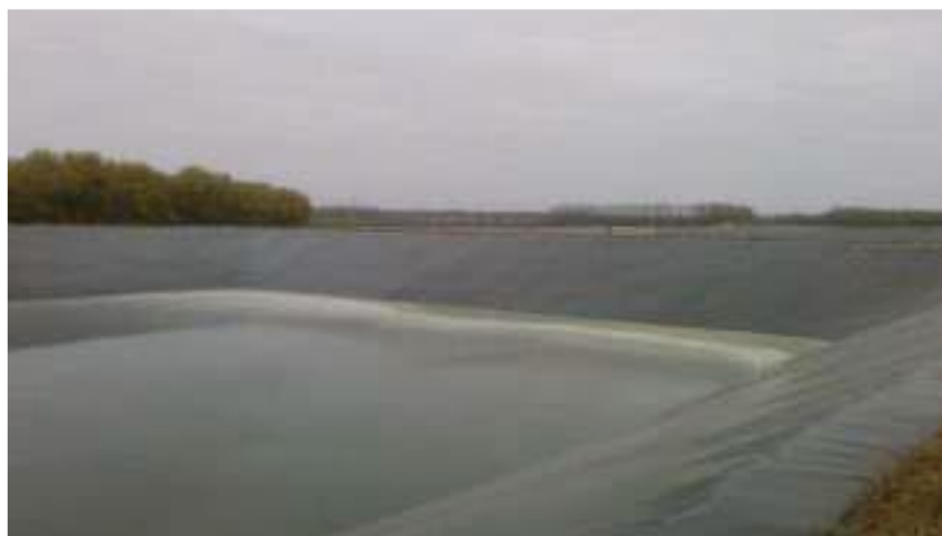
Рисунок 3 — Лагуна с пленочным покрытием
